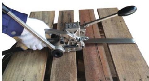
⑤ 結束機の取り外し
